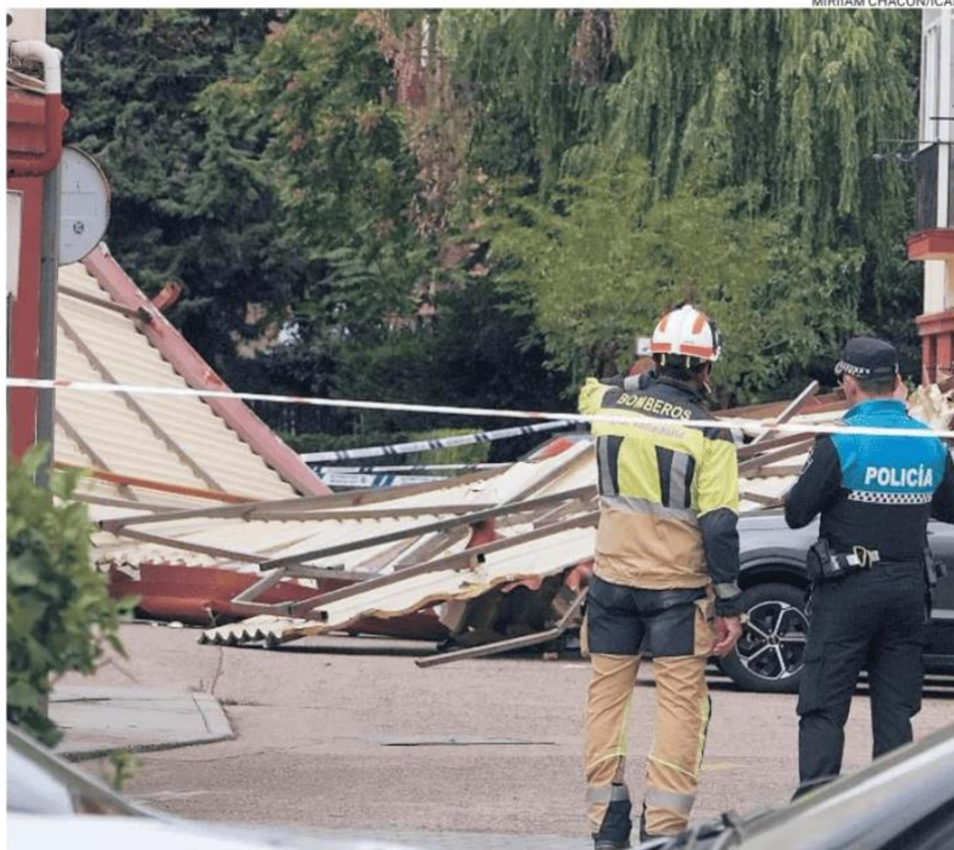
Caída de un tejado de uralita en un edificio céntrico en Valladolid
